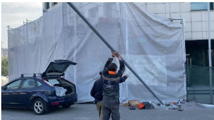
8. При помощи уровня отрегулируйте вертикальный уровень мачты и зафиксируйте гайки. Установите контр-гайки.
