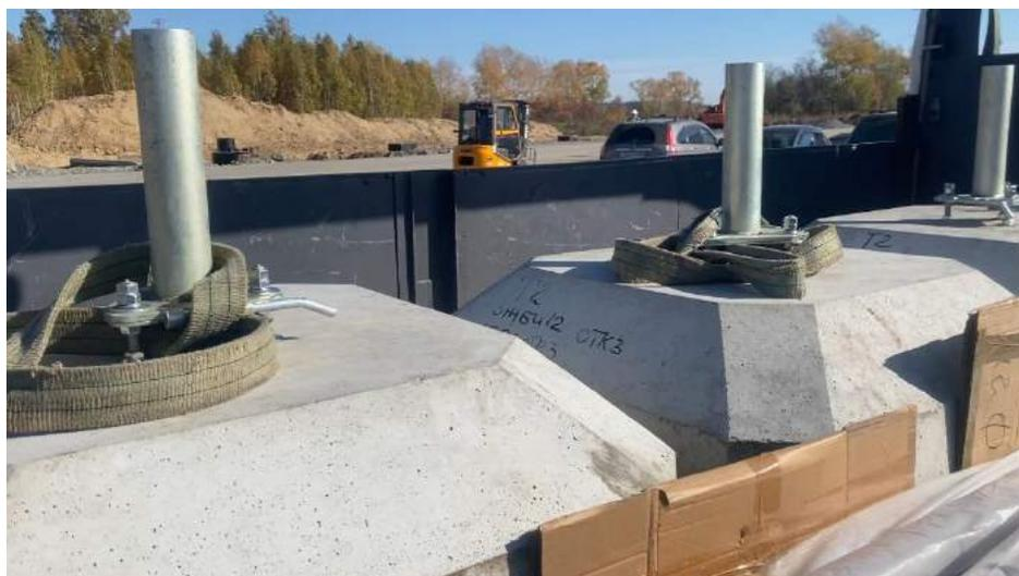
4. Для установки мачты необходимо открутить две верхние гайки каждой шпильки чтобы наклонить верхнюю часть откидного основания. Далее установите мачту в откидное основание и аккуратно поднимите ее в вертикальное положение.
