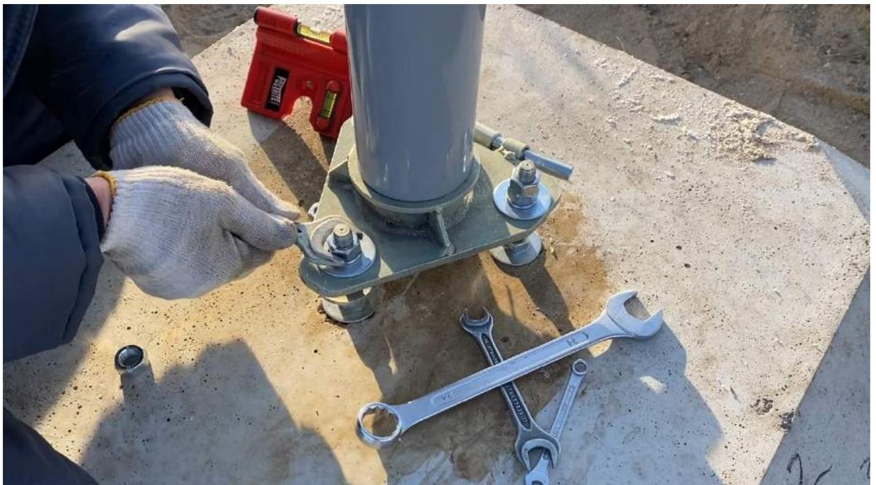
На фотографии ниже представлена схема крепления откидного основания к бетонной тумбе.
